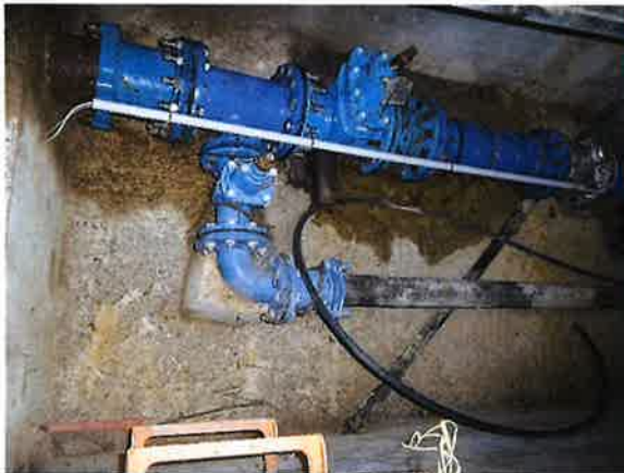
Esquema arqueta de caudalímetro
